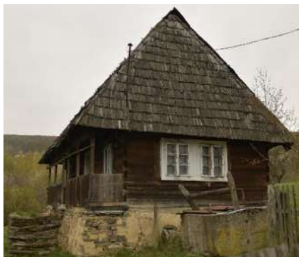
Figura 8. Ferestre cuplate, cu două canate subîmpărțite, cu tâmplărie de lemn vopsită în alb
